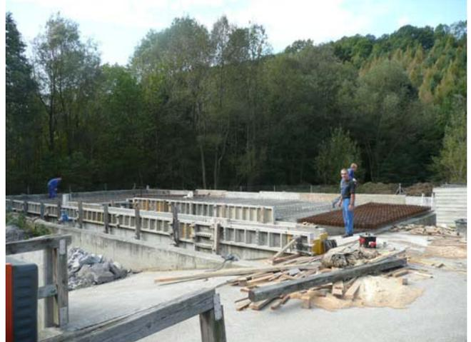
*Die Firma Böchheimer bei den Fundamentierungsarbeiten für die Schlammbehandlungsanlage*
