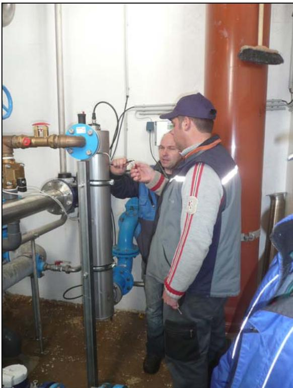
*Im Dezember wurden neue Ultraviolett-Entkeimungsanlagen bei den Wasserversorgungsanlagen Hochneukirchen und Hattmannsdorf in Betrieb genommen.*
