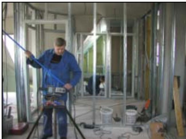
*Der Einbau der Wohnungen im Dachgeschoß schreitet zügig voran. Nach dem Aufstellen der Ständerprofile werden die Installationsarbeiten vorgenommen.*
