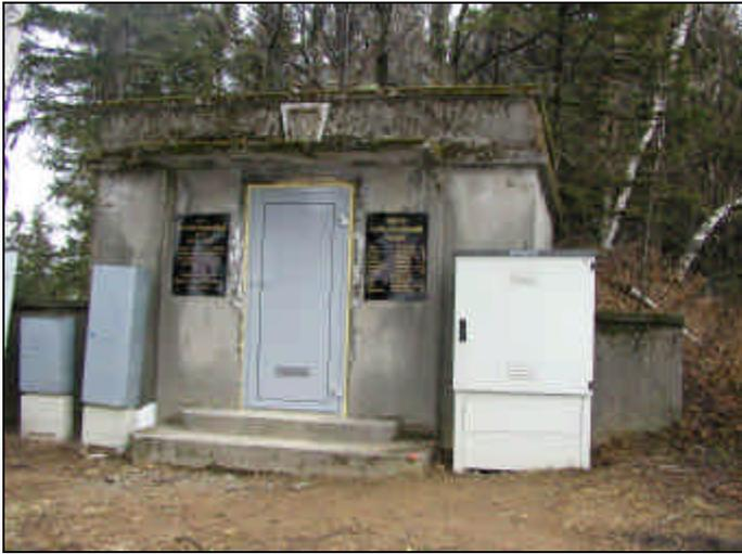
*Der Hochbehälter Gscheidt mit den diversen Schalt- und Steuerschränken nach der Einleitung der Transportleitung von der Pumpstation Loipersdorf*
