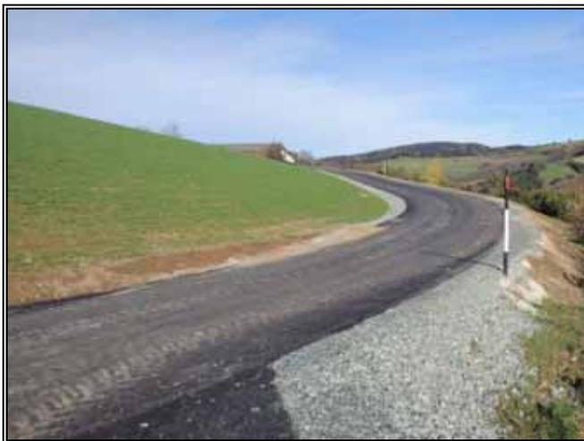
Der Güterweg Rotleiten erhielt mit finanzieller Unterstützung des Landes eine verstärkte Tragschicht und eine neue Asphaltdecke.
