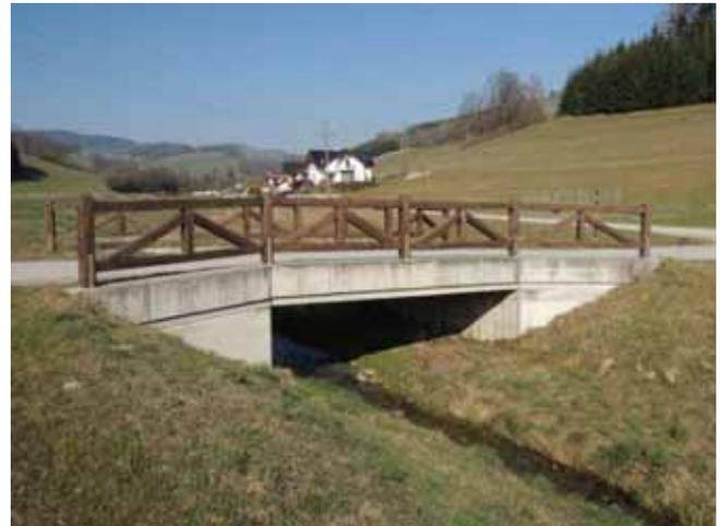
*Das Geländer der Brücke beim Feuerwehrhaus in Maltern ist zum Teil schon morsch und soll durch ein Metallgeländer ersetzt werden.*
