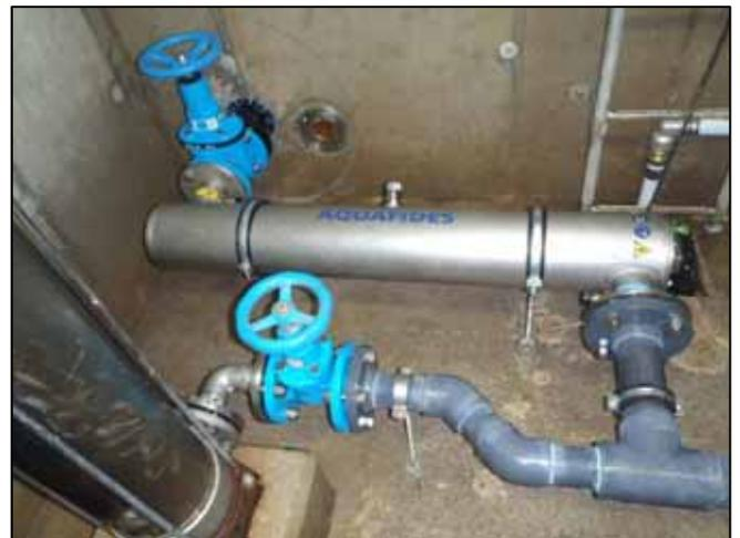
*Für den Einbau der UV-Anlagen waren einige Umbauarbeiten an den Installationen im Tiefbehälter Loipersdorf erforderlich.*
