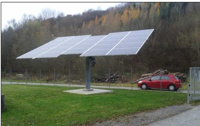
Die Anlage mit einer **Leistung von 6 kWp** wurde von der **Fa. Elektro Pinter** geliefert und montiert; das Fundament für den Tracker wurde von der Fa. Ulrich hergestellt. Da über ein Webportal die erzeugte Strommenge jederzeit abgelesen werden kann, können wir feststellen, dass bisher **996 kWh Strom** mit der Anlage erzeugt wurden. Da die Kläranlage relativ gleichmäßig Strom verbraucht, ist ein Einspeisen in das EVN-Netz nicht notwendig.
