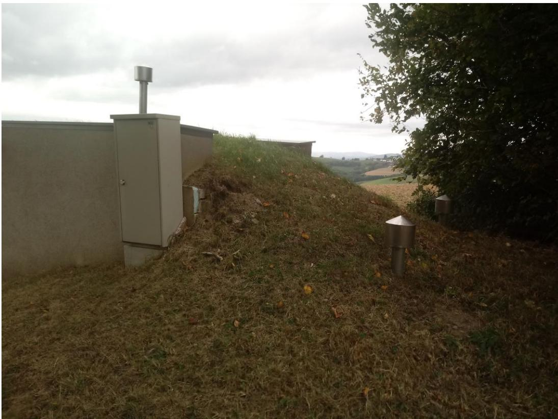
Abbildung 2: WVA Hochneukirchen - Gschaidt West, Hochbehälter Grametschlag, Belüftungseinrichtungen.
