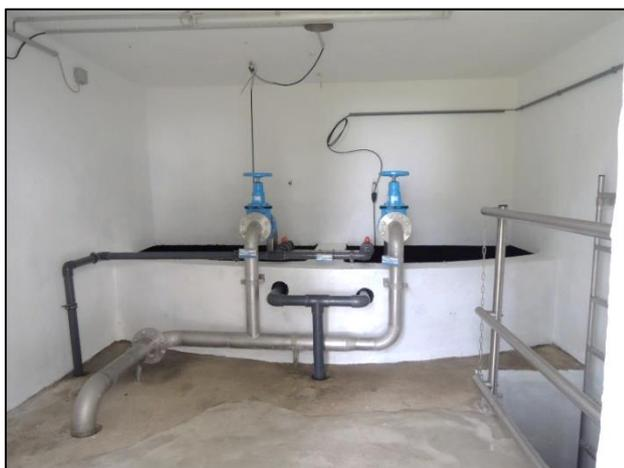
*Wasserzulauf in den Hochbehälter Gschaidt. Auch in diesem Behälter ist eine Fernauslesung der an das Ortsnetz abfließenden Wassermenge installiert.*
