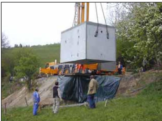
Die Abwasser-Pumpstation in Burgerschlag wurde im April als Fertigteilbauwerk geliefert und eingebaut
