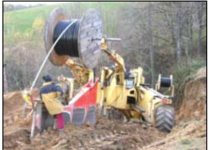
*Die Gefälledruckleitung wird im Pflugverfahren verlegt.*
